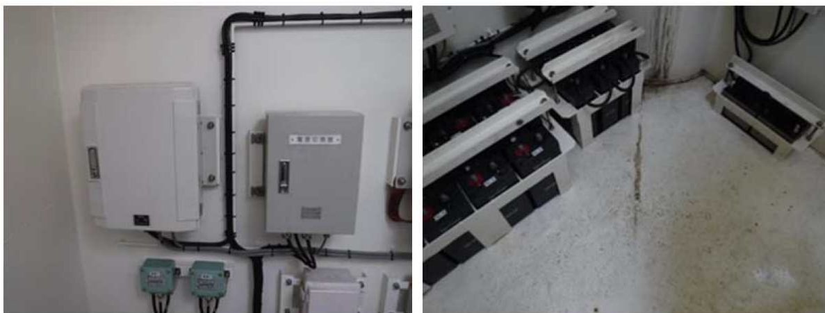
図- 3.6.1 室内機器の点検
