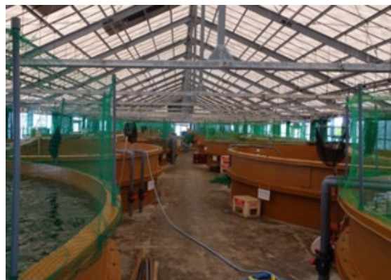
図Ⅱ.4.4 施設内の水槽
