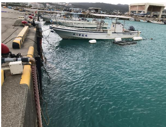
図Ⅱ.4.6 漁港内の取水場所
