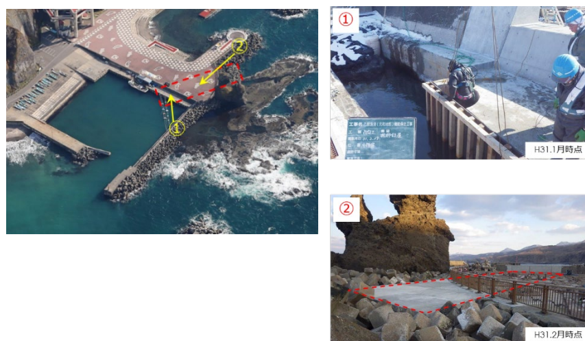
図 II. 3. 6 施工状況 出典：北海道提供
