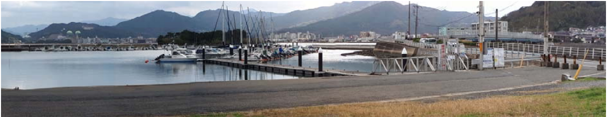
東側浮棧橋 L=91.6m (遠景)、西側浮棧橋 L=184.6m (手前)
