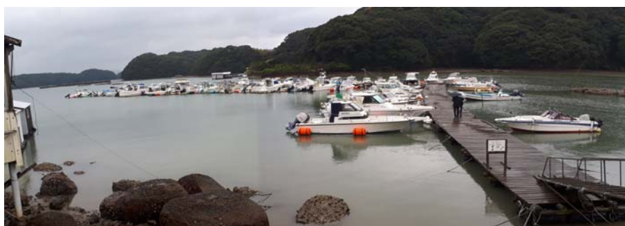
組合設置の浮棧橋（港外側）
