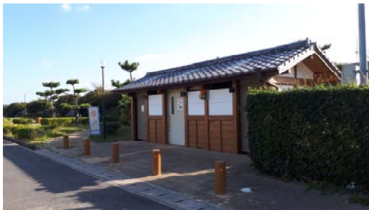
駐車場背後のトイレ
