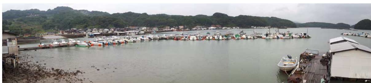
組合設置の浮棧橋（港内側）
