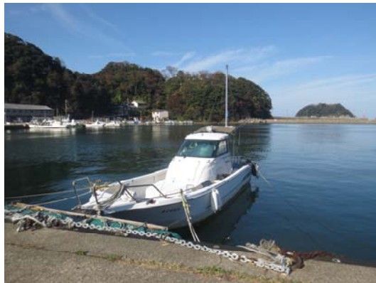
-3.0m岸壁中央付近
