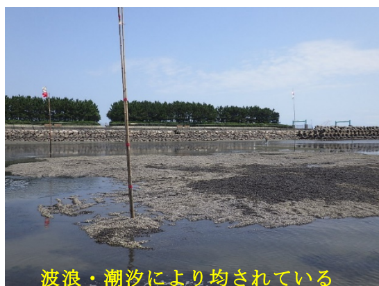
写真 2.3.2-3 砕石敷設状況(工事完了後1週間後)
