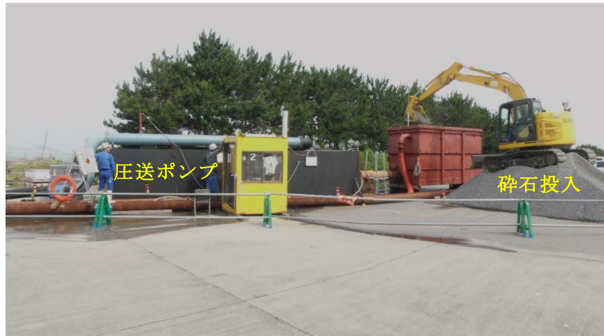
写真 2.3.2-1 圧送ポンプユニット
