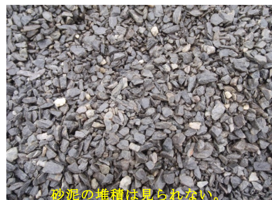
写真 2.3.2-3 砕石敷設状況(工事完了後1週間後)
