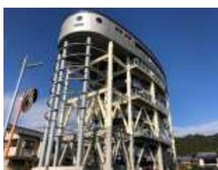
津波避難タワー
