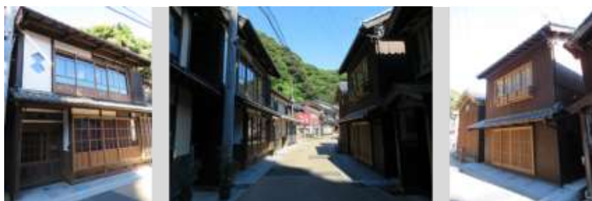
図ア-(イ)-2)-8 母屋と舟屋を改修した簡易宿所(鳥屋地区)
