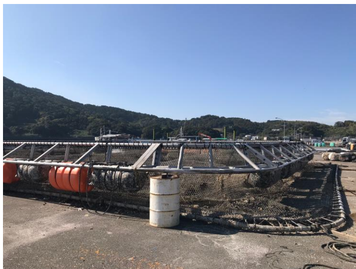
写真 e-2-5 浮沈式生簀（15m×15m）
