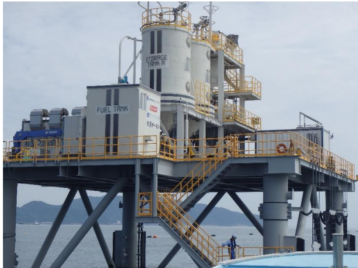
写真 e-2-3 プラットフォーム
