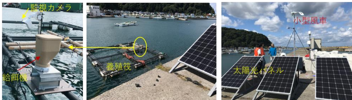
写真 e-1-3-1-1 システムの外観
