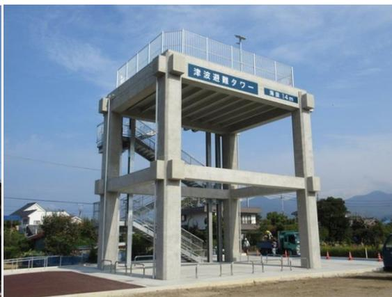
写真-2 鉄筋コンクリートタイプ
