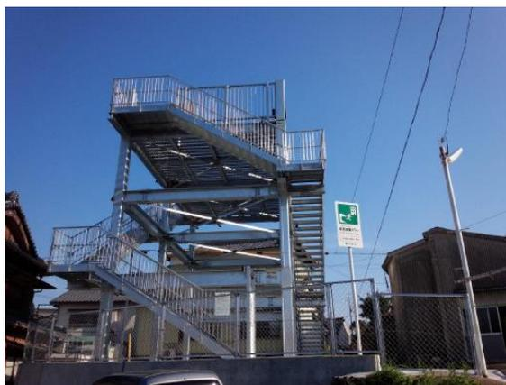
写真-1 鉄骨造タイプ
