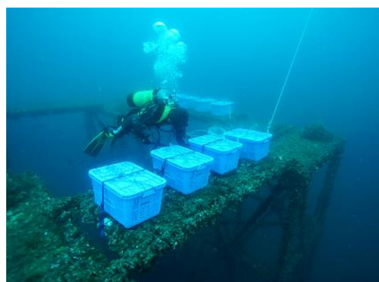
写真 3.2-4 鋼製魚礁への籠の固定
