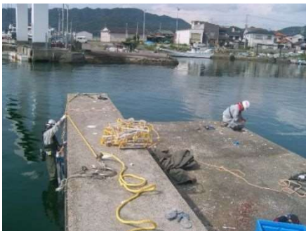
図 d-1-3-28 計測状況（左：縦断ひび割れ、右：横断ひび割れ）
