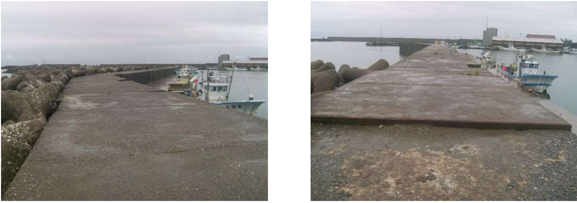
図 d-1-3-11 施設全景（左：起点⇒終点方向、右：対象スパン⇒終点方向）
