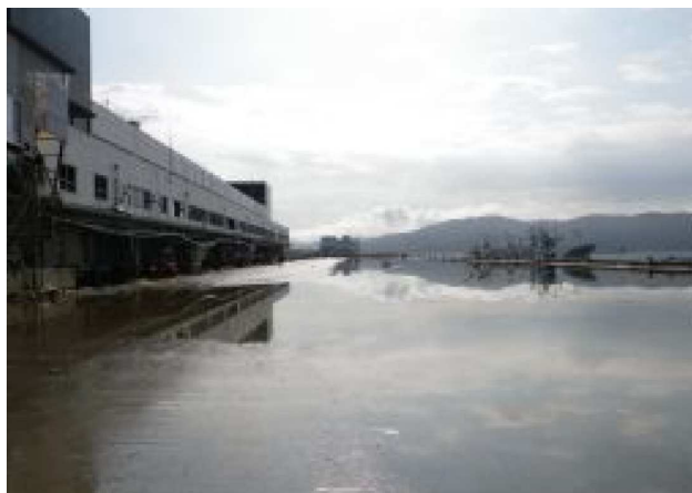
図（２）－ ９ 荷捌き所の被害の例（石巻漁港）
