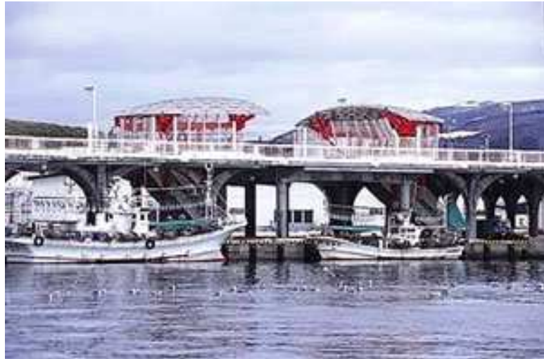
図（２）－７ 人工地盤の例（奥尻漁港）
