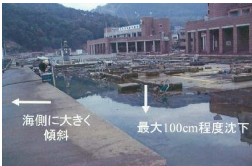
図（2）－8 液状化による被害の例（女川漁港）
