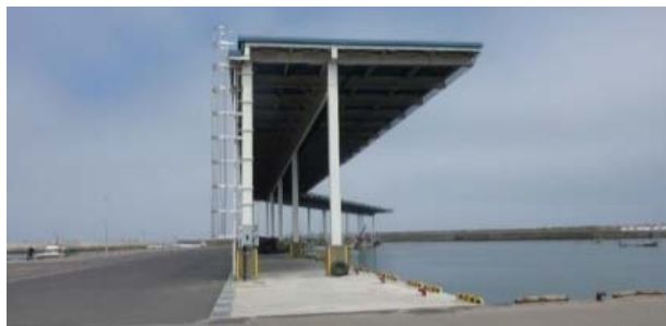
写真 屋根付岸壁の整備例（八雲漁港）
