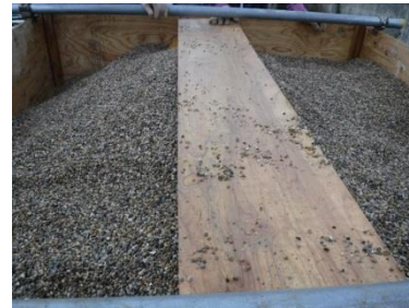
砂利積込状況
