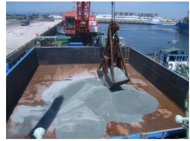
砕石の積込状況
