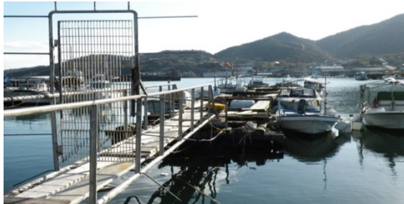
鍵の付いたゲートを設けた栈橋
