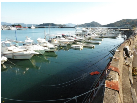
護岸の前面に係留する放置艇
