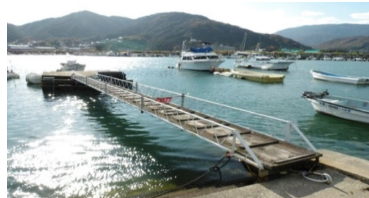
「立入禁止」の案内を掲げた栈橋
