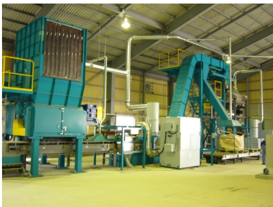
FRP断片を細かく粉碎する中間処理施設
