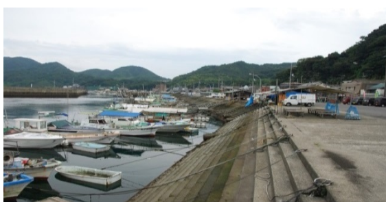
階段式護岸の宮窪漁港
