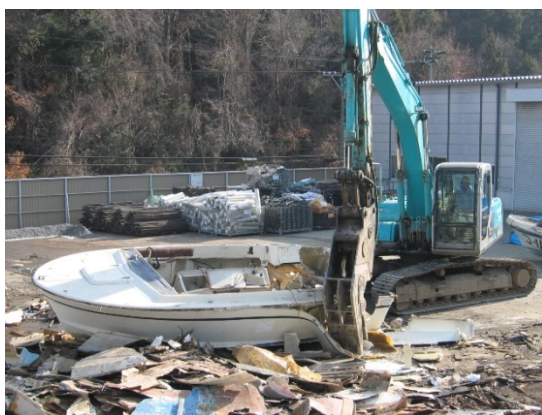
重機による粗破碎の作業
