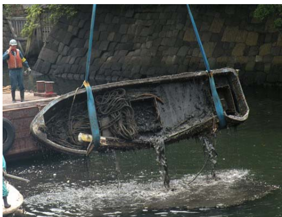
沈船の引き揚げ作業。堆積したヘドロが流れ出る
