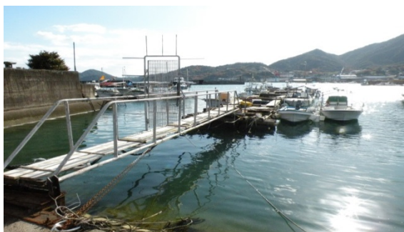
放置艇が係留されている栈橋
