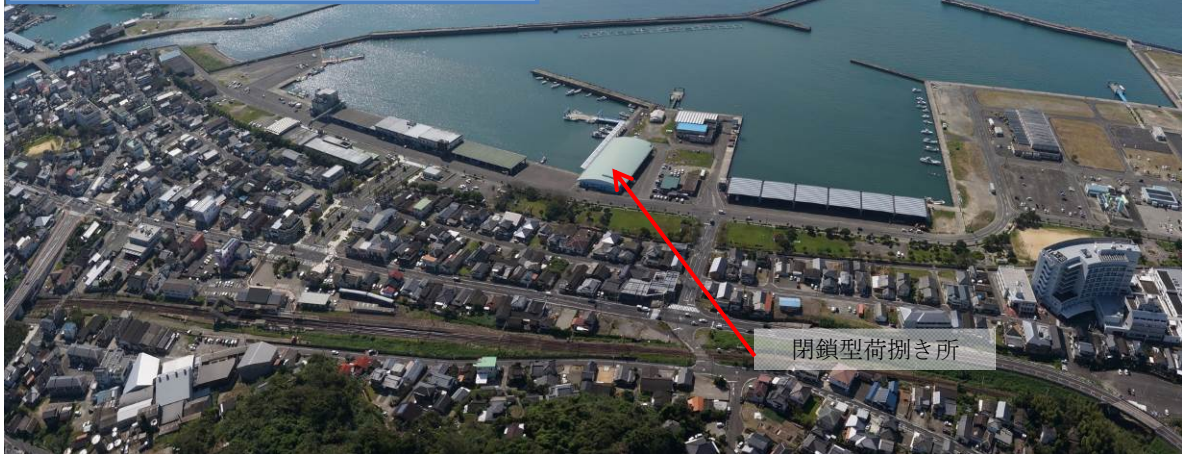
屋根の設置状況（荷さばき所前）
