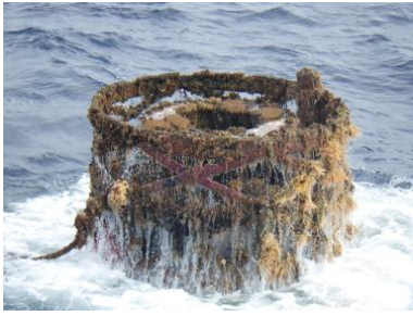
写真-6 回収された中層浮魚礁の状況（H26、沖縄県、剛体タイプ） （左：礁体浮上時、中：係留索の付着物、右：アンカー）
