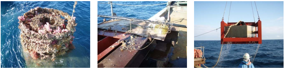
写真-4 回収された中層浮魚礁の状況（H25、宮崎県、剛体タイプ） （左：礁体浮上時、中：係留索の漁具絡み、右：アンカー）
