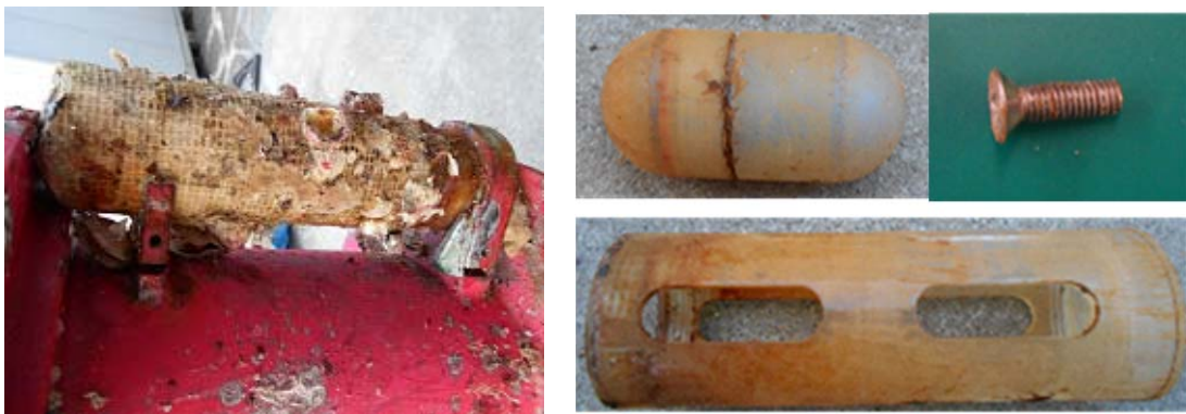
写真-10 フロートスイッチ部の状態（設置後19か月経過）
