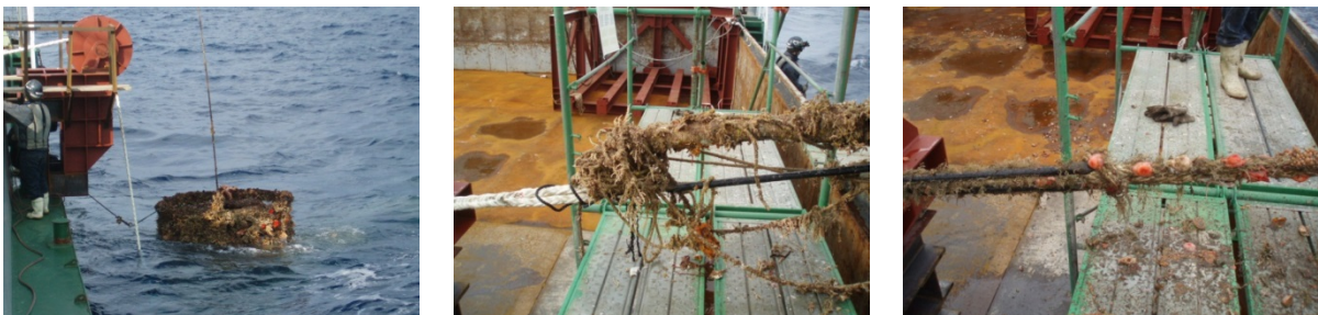
写真-2 回収された中層浮魚礁の状況（H25、沖縄県、剛体タイプ） （左上：礁体浮上時、右上：係留索の漁具絡み、 左下：下部主係留索の付着物、右下：回収された礁体）
