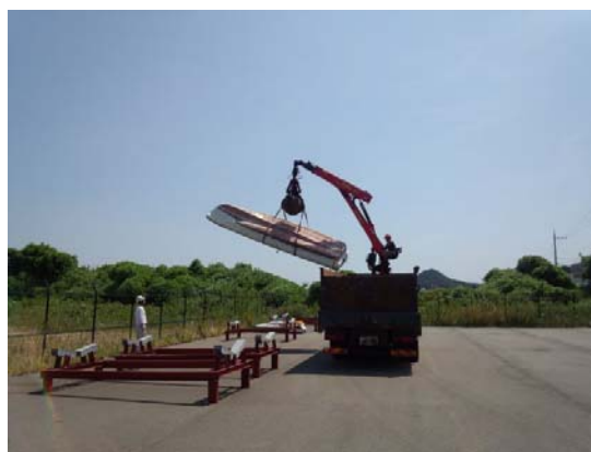
請負業者のユニック付きトラッ
