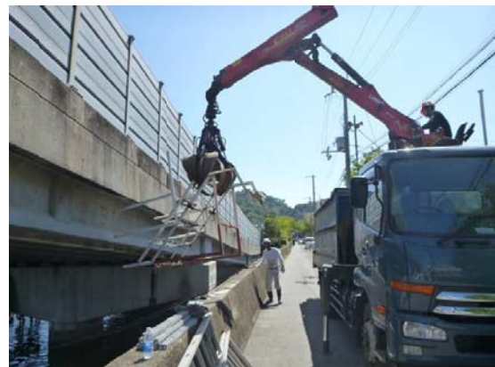
トラックに積み込まれる撤去物
