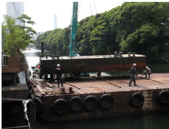
クレーン台船による鋼製栈橋の撤去作業
