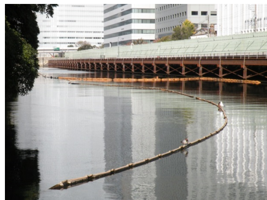
ボートの侵入を防ぐ河口付近の オイルフェンス
