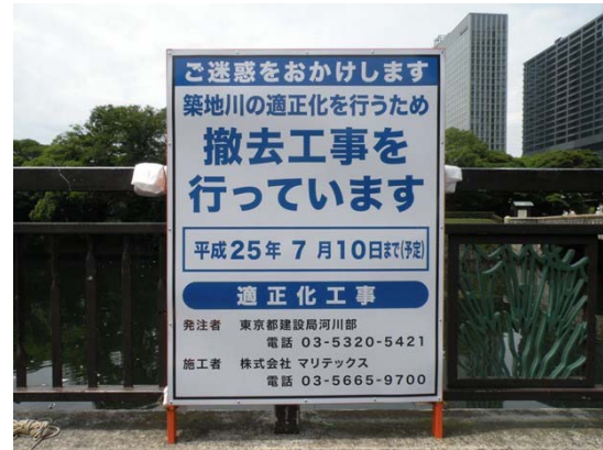
行政代執行の期間中に設置された撤去工事の看板
