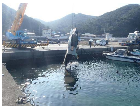
沈船の引き揚げ作業
