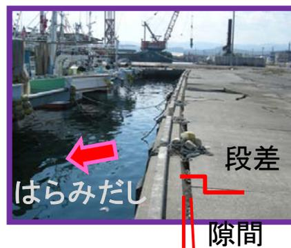
図 4-5 はらみだし量と段差、隙間
