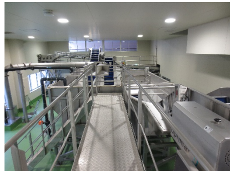
A棟荷さばき所内
