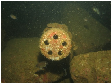
写真① 塩ビパイプの設置状況
