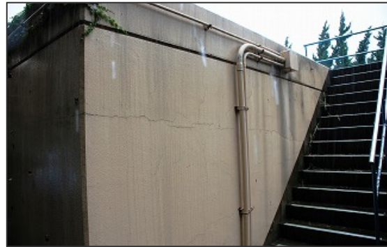
写真-4 処理水槽躯体に発生したクラック
