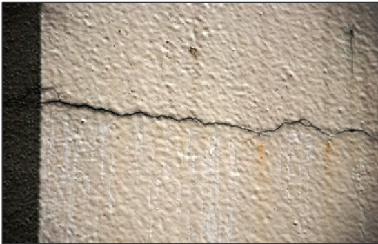
写真-4 処理水槽躯体に発生したクラック
