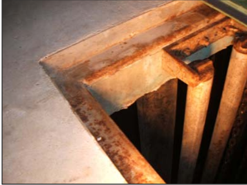
写真 - 3 水中ポンプ及び計量槽の発錆状況
