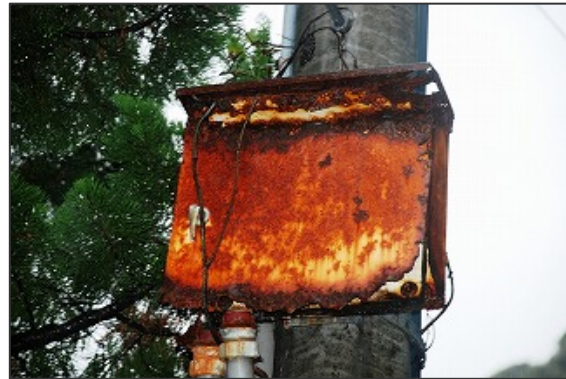
写真-8 電柱装柱類（塩害）
