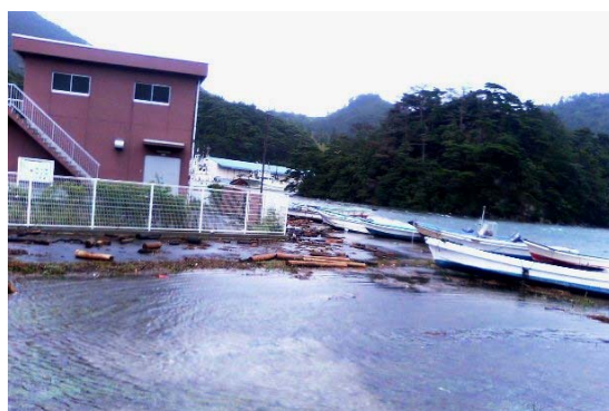
写真-13 場内の冠水による被害状況
