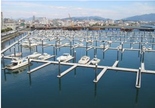
貯木場の跡地に設置された係留棧橋
