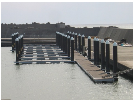
A 漁港に設置されたビジター棧橋
