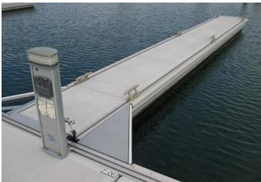
棧橋は、安定性に優れたコンクリート製
