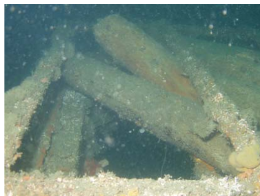
固定ユニットから脱落した木材
