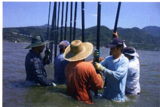
(漁場整備における淡水防護策設置)
