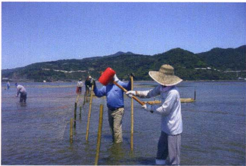
(被覆網の設置作業)
