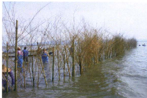
(竹シバの設置作業)
