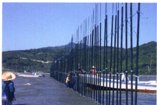
(漁場整備における淡水防護策設置)
