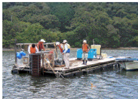
写真-5 装置の設置状況
