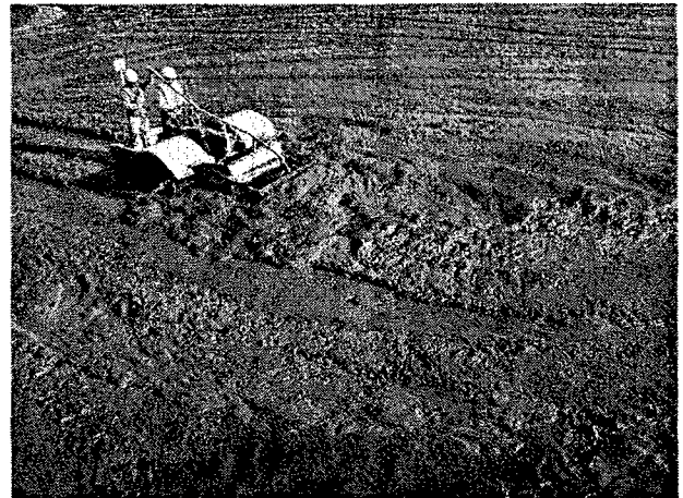
図6 干潟走行機(排土板付き)による浮泥除去工法
