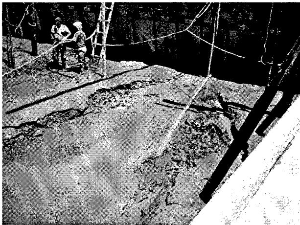
図2 固定式水中ポンプによる浮泥除去工法
