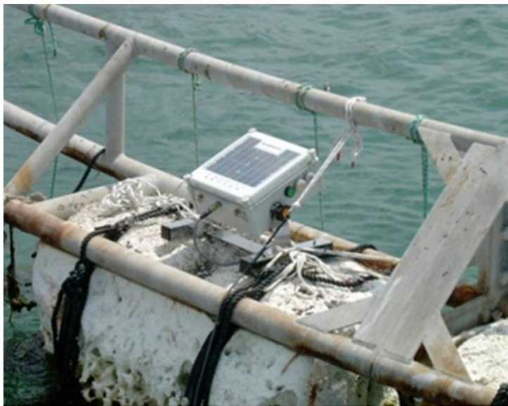
リモート監視装置
