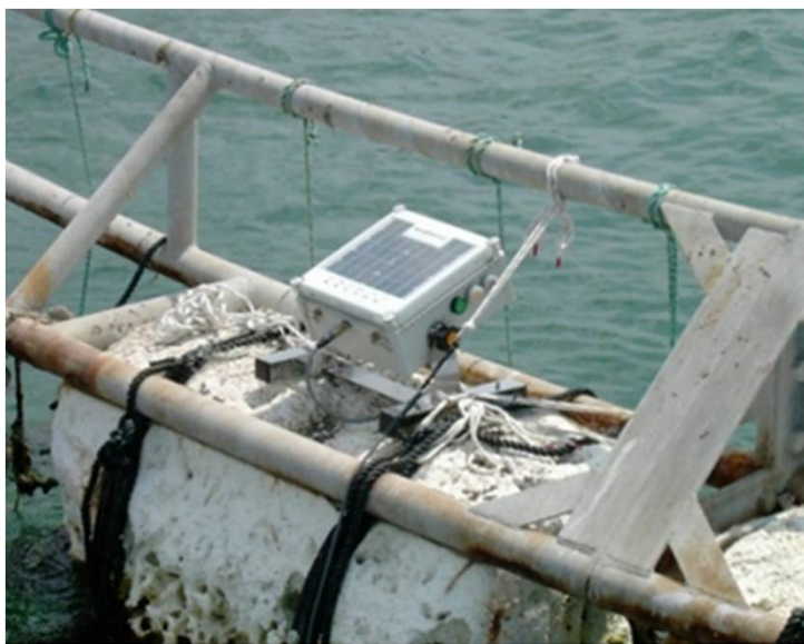
リモート監視装置
