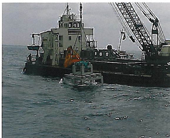
Figure 8 Immersion des blocs en béton
