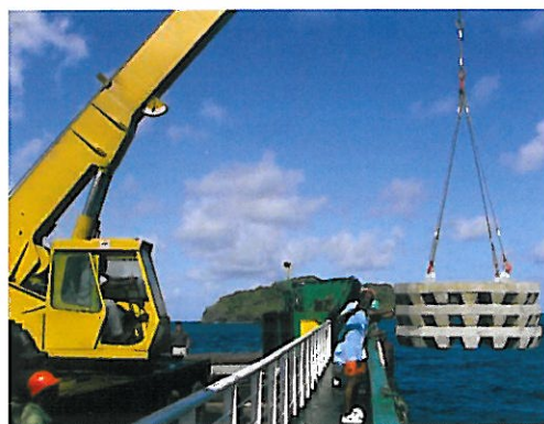
Figure 26-1 (haut), Figure 26-2 (bas) Méthode d'immersion
