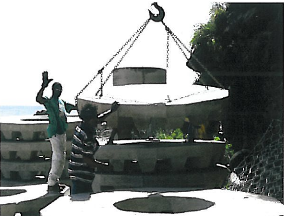
Figure 32 Vue de la construction des récifs à langoustes
