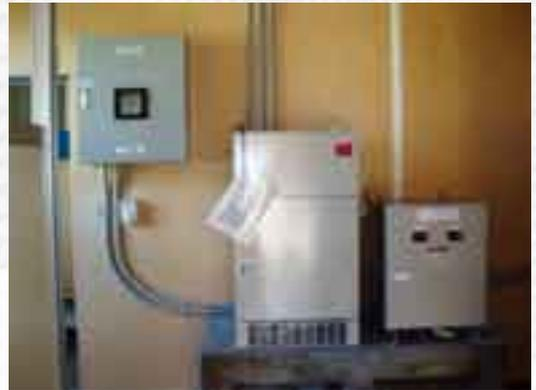
Dispositif de protection, conditionneur électrique, transformateur
