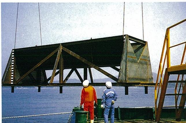
■底層流制御構造物概略図 V-130 型
