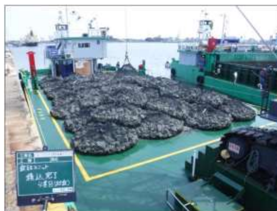
図 5-9 袋詰めユニットの積み込・海上運搬状況
