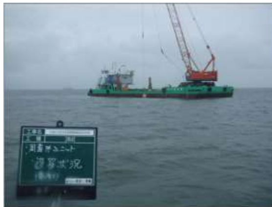
図 5-10 袋詰めユニット、生物付着小袋の据付状況
