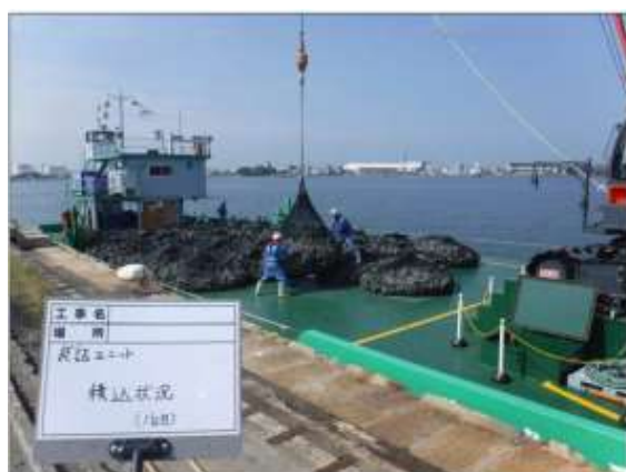
図 5-9 袋詰めユニットの積み込・海上運搬状況
