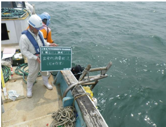
写真 1.1-2(4)(5) 潜水確認（沈下板計測：凹凸覆砂畝型）
