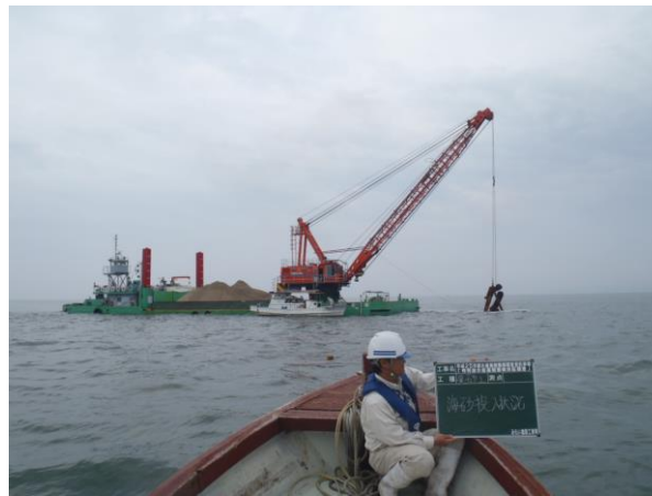
写真 1.1-1(3) 覆砂状況（スパット付ガットバージ）
