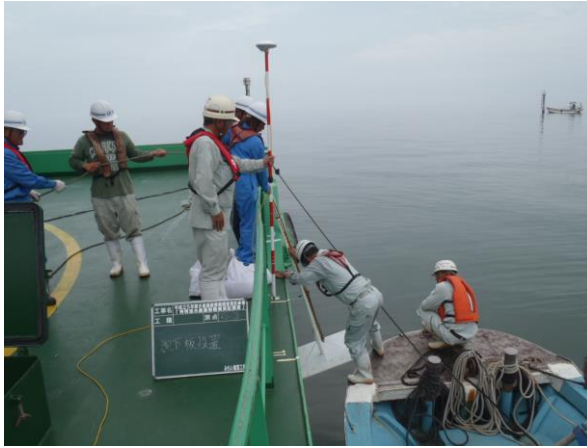
写真 1.1-1(1) 沈下板設置状況
