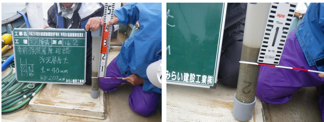
写真 2.2-6 目視による浮泥・シルトの堆積厚の測定
