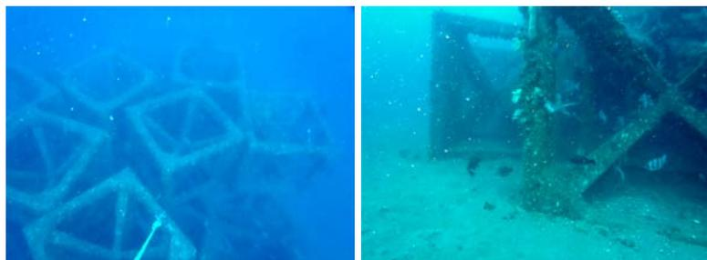
平成23年11月に実施したROV調査と比較すると、現状でもほぼ同様な配置状況(2層目は落下していない)。砂質底への埋没は10cm程
