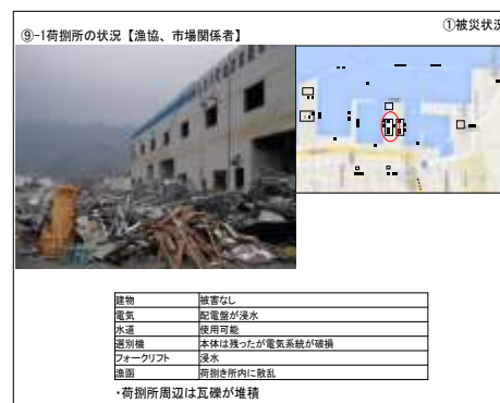
(被災状況の説明資料)
