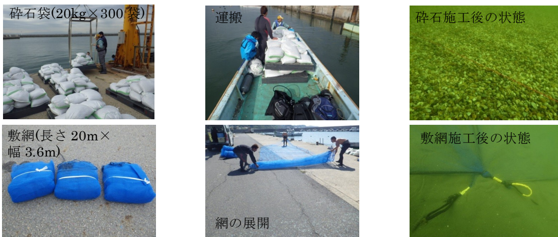
写真5 カシパン除去区での碎石施工(上)および敷網施工(下)の状況
