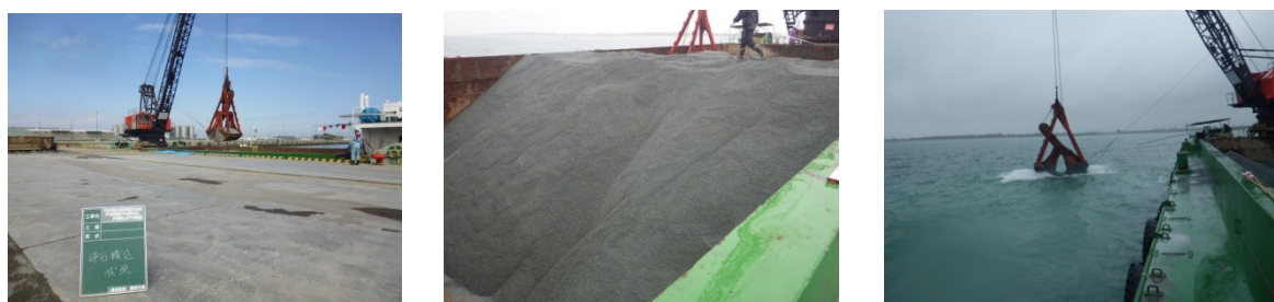
写真3 岸側覆砂の施工状況
