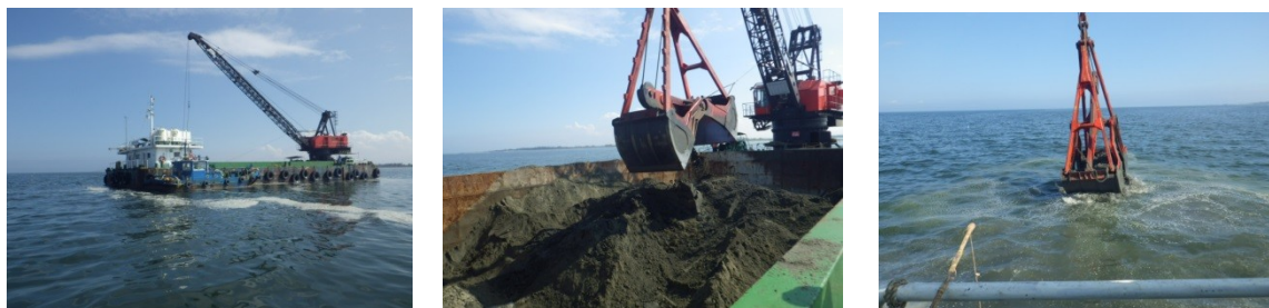
写真2 沖側覆砂の施工状況
