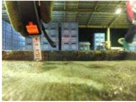
写真 1-1-6 フォークリフトの走行に支障のない事例（岩手県 K 漁港、段差 2cm）
