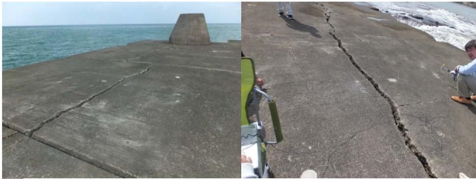
写真 1-1-1 スパン 3 (TB3) のひび割れ (5.0 cm) の写真
