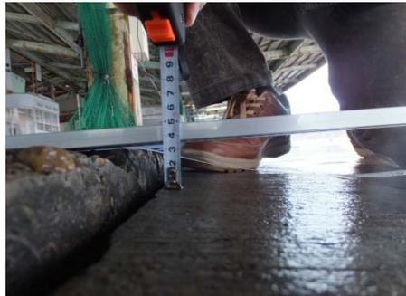
写真 1-1-7 フォークリフトの走行に支障のある事例（岩手県 K 漁港、段差 3.5cm）
