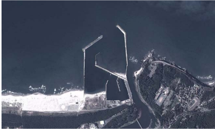
図-5.2 吹浦漁港の衛星写真(google earth)
