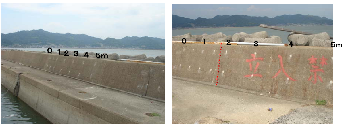
(1) B-2-2 (測定範囲内で目視によるひび割れ無し) (2) B-1-1 (測定範囲内で目視によるひび割れ有り)
