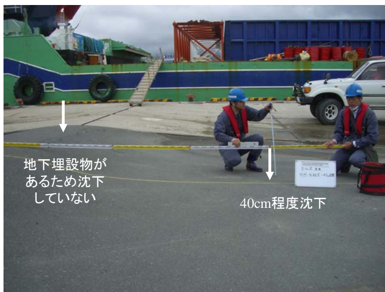
写真-2.2.4 液状化による埋立地の被害例 (気仙沼)
