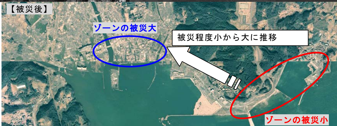
図-3.4.2.6 志津川漁港の被災状況
