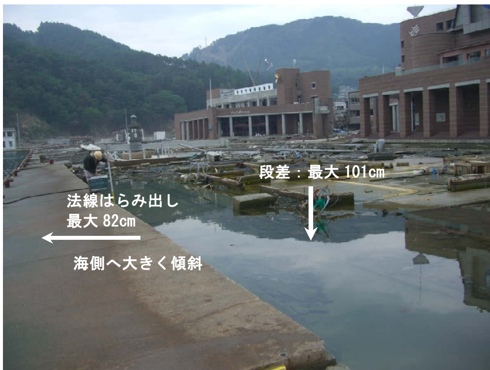
写真-3.1.2.3 重力式構造物の被害例【女川漁港-4.0m 岸壁(施設番号：4-21)】
