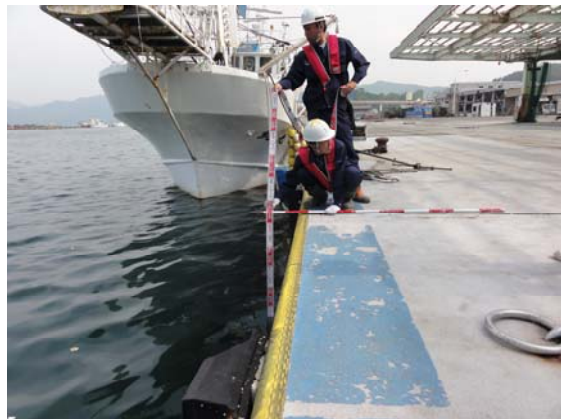
(b)レッド測深状況(前面洗掘の確認)
