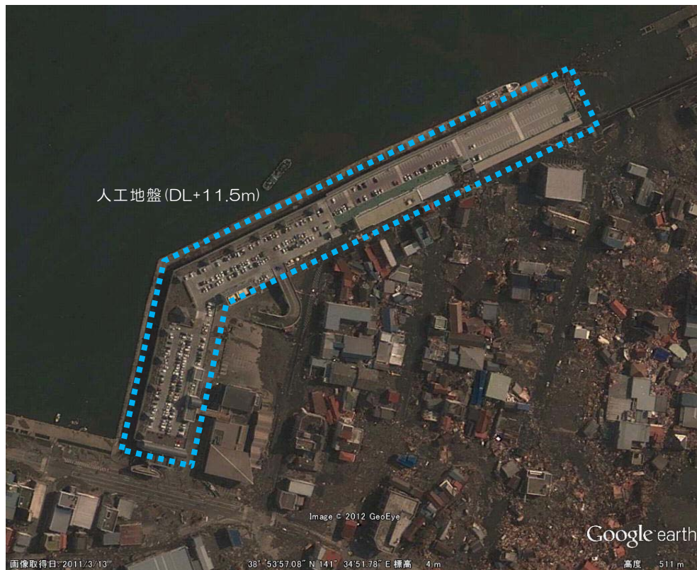
図-3.4.1.4 気仙沼漁港の人工地盤(撮影日:2011.03.13)
