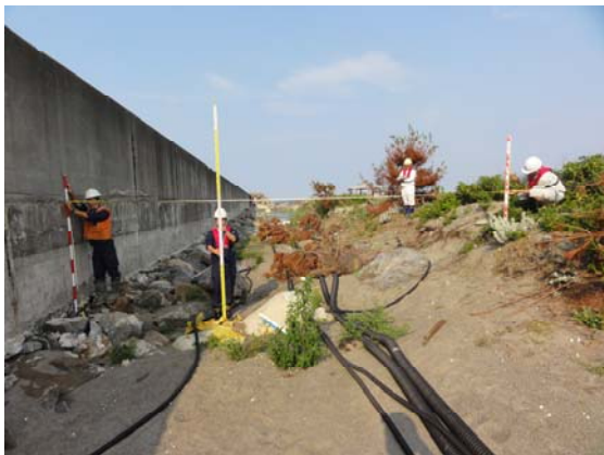
(a)目視調査状況(洗掘規模の計測)
