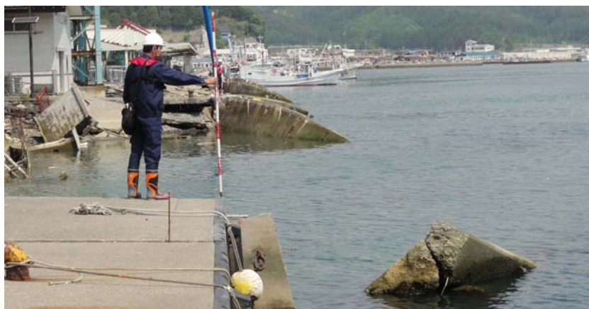
図-3.1.1.8 矢板式岸壁の被災メカニズム(山田漁港-5m 岸壁)
