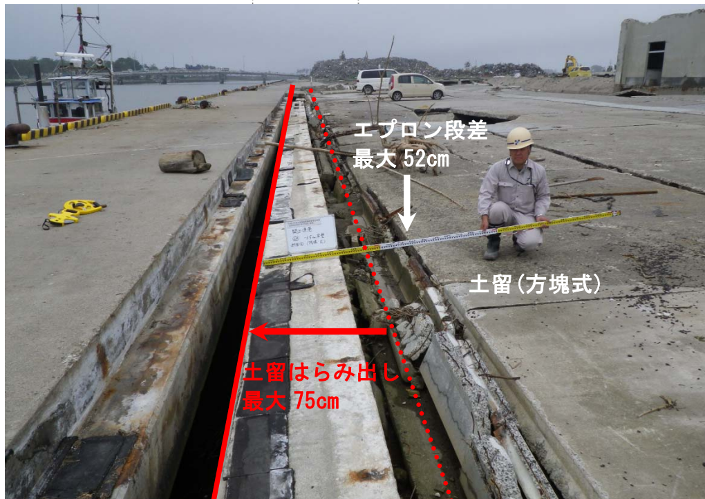
写真-3.1.2.1 棧橋式構造物の被害例【関上漁港-3.5m 岸壁(施設番号：69)】
