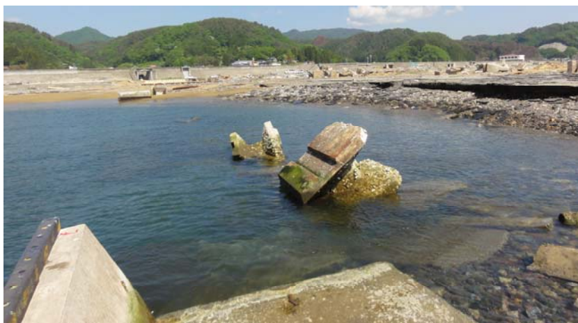
図-3.1.1.7 直立消波式岸壁の被災メカニズム(田老漁港-4m岸壁)
