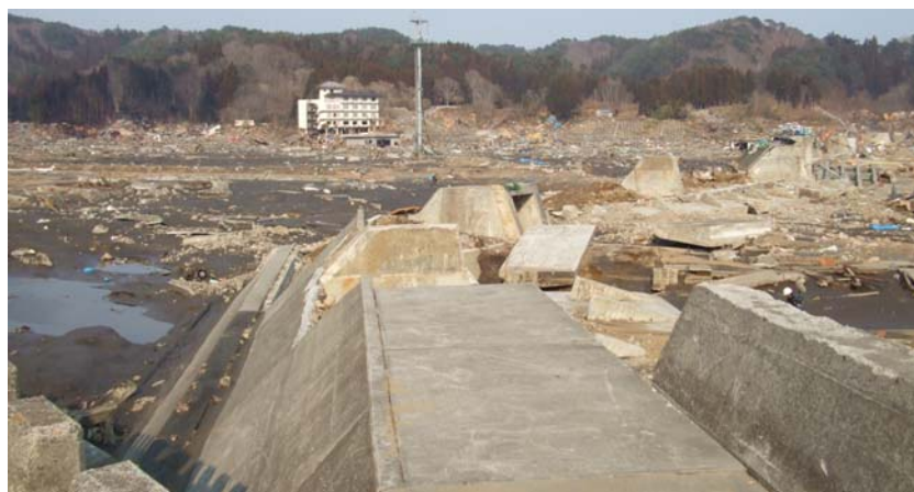
図-3. 1. 1. 13 傾斜式防潮堤の被災メカニズム(田老漁港防潮堤)
