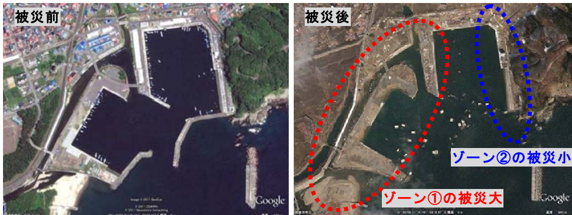
図-3.4.2.3 田老漁港の被災状況
