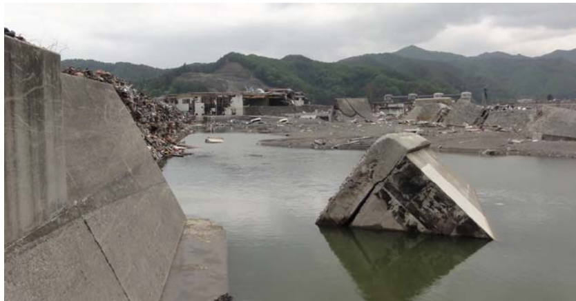
図-3. 1. 1. 12 重力式防潮堤の被災メカニズム(大槌漁港防潮堤)
