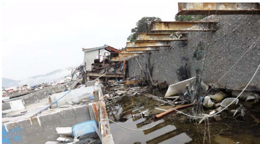
図-3.1.1.11 重力式防潮堤の被災メカニズム(山田漁港防潮堤)
