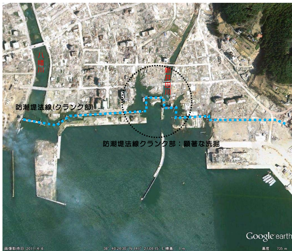
図-3.4.1.5 志津川漁港の防潮堤法線(撮影日:2011.04.06)
