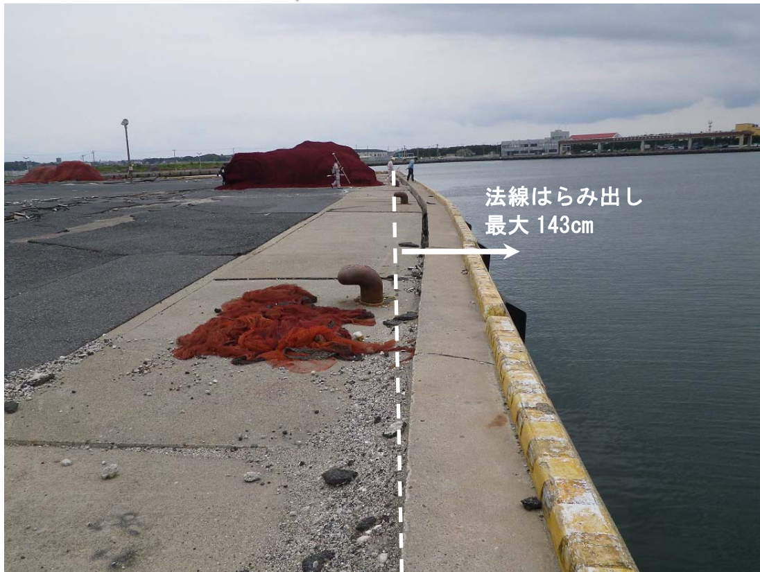
写真-3.1.2.2 矢板構造物の被害事例【波崎漁港-5.0m 岸壁(施設番号：N13)】
