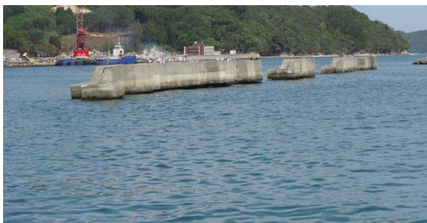
図-3.1.1.5 矢板式防波堤の被災メカニズム(大槌漁港南防波堤)
