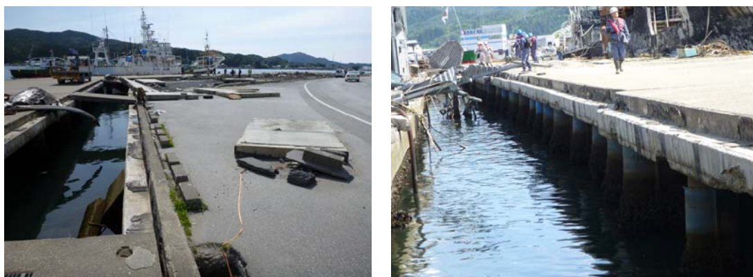
図-3.1.1.9 棧橋式岸壁の被災メカニズム(気仙沼漁港-6m 岸壁(南町地区))
