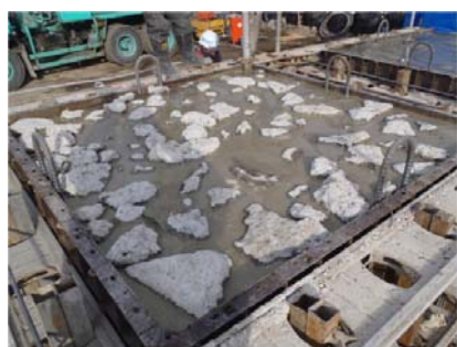
モルタル打設状況
