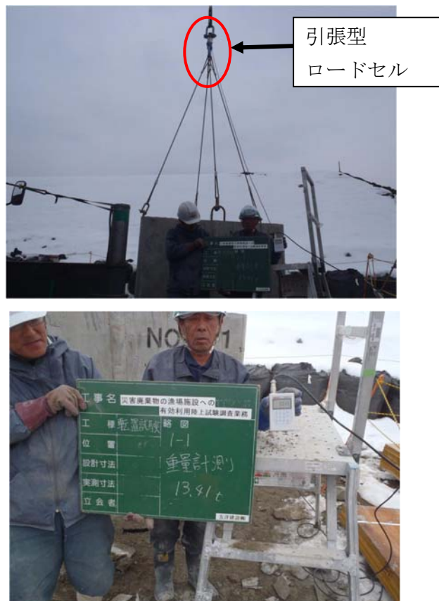
図 2.20 ロードセルによる重量測定状況
