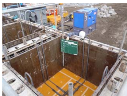
型枠組立完了
