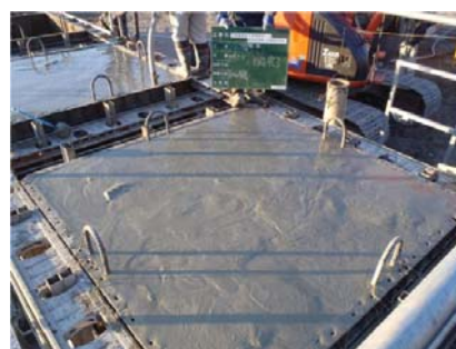
モルタル打設完了
