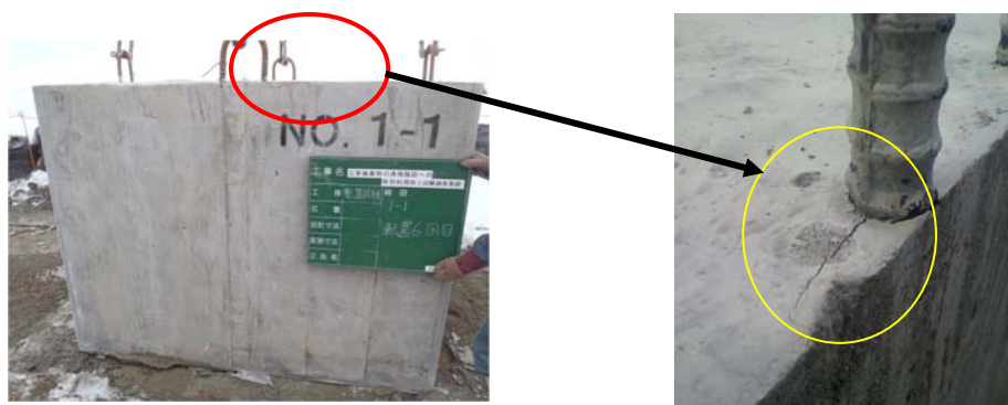
図 2.24 吊筋位置での局所的なひび割れ状況
