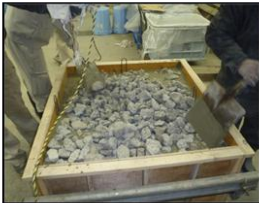
打設状況（人力によるがらの押し込み）
