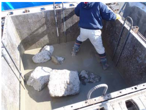
500mm コンクリートがら均し状況
