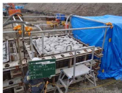
コンクリートがら投入完了
