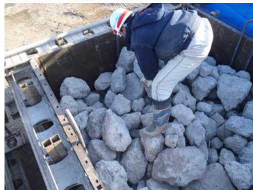
300mm コンクリートがら均し状況
