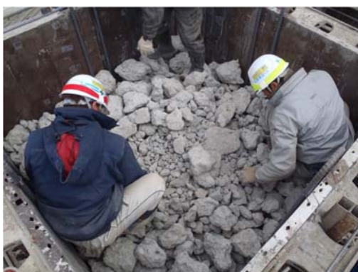
50~300mm コンクリートがら均し状況
