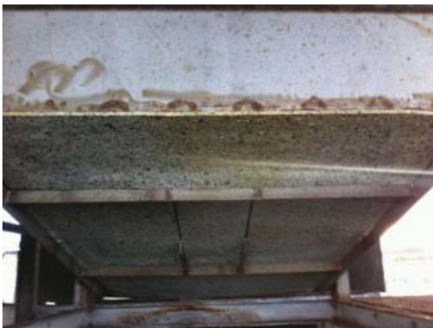
写真 2-10 吸音版張り付け後
