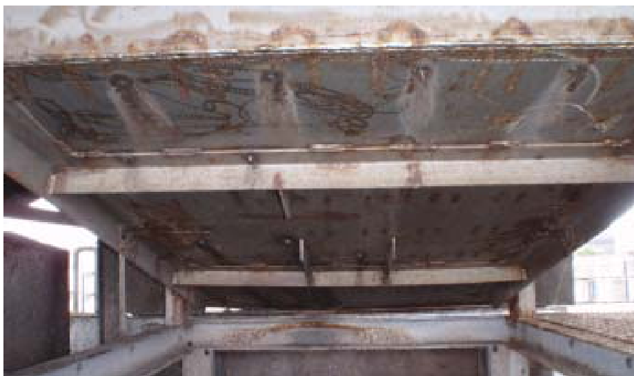
写真 2-9 吸音版張り付け前
