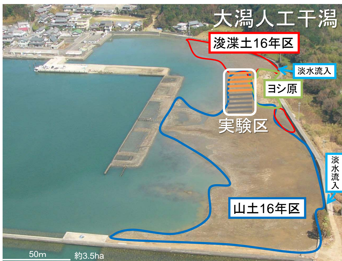
図4. 野外底質操作実験における実験区設置場所
