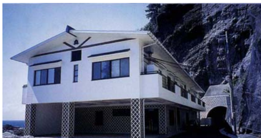
図－1． E 地区漁業集落排水処理施設
