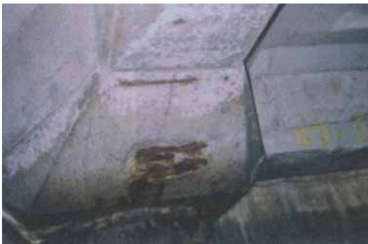
図-3.4(1) 鉄筋コンクリート変状ランク例
