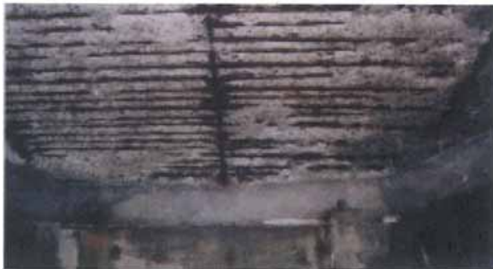
スラブ変状ランク a (例) かぶりの剥落
