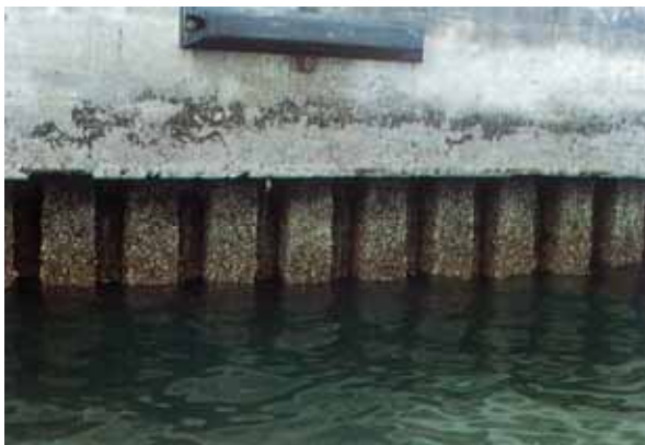
図-1.5 鋼構造物変状ランク例
