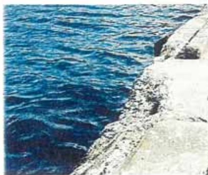
図-1.3 無筋コンクリート変状ランク例
