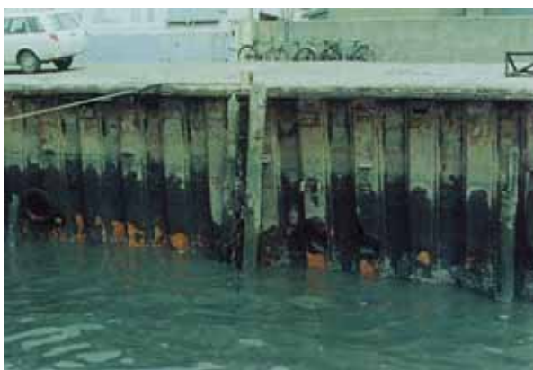
『鋼矢板』変状ランク b (例) 平均干潮面付近から L.W.L 付近の赤褐色の発錆
