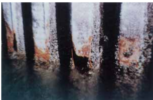
『鋼矢板』変状ランク a (例) 腐食による開孔
