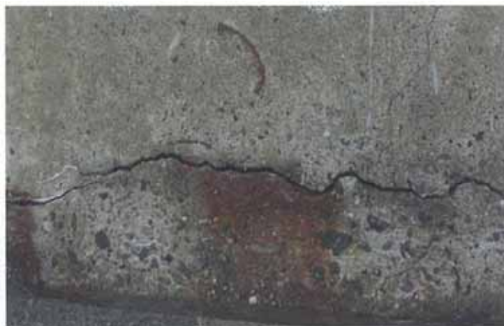
はり変状ランク a (例) 軸方向の幅 3mm 以上の ひび割れ
