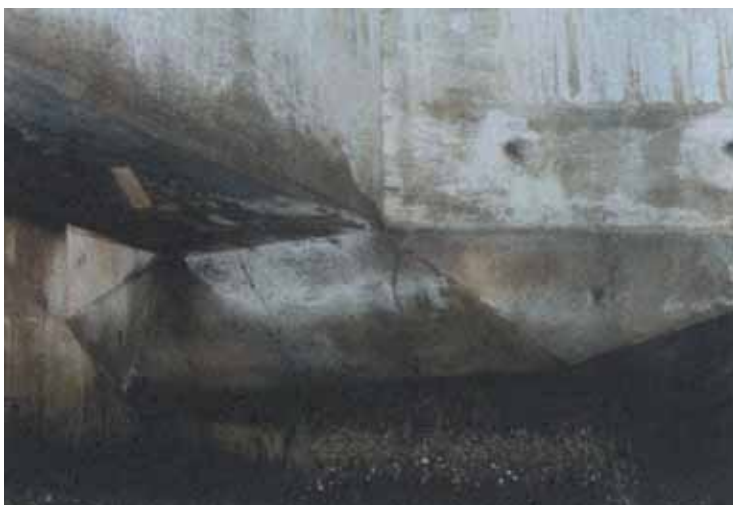
図-1.4(3) 鉄筋コンクリート変状ランク例
