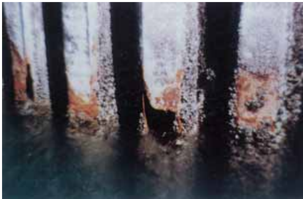
鋼矢板変状ランク a (例) 腐食による開孔
