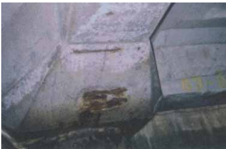
ハンチ変状ランク a (例) かぶりの剥落
